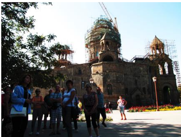
Fot.43 – Katedra Eczmiadzyn w remoncie
